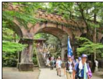
水路閣(南禅寺)
